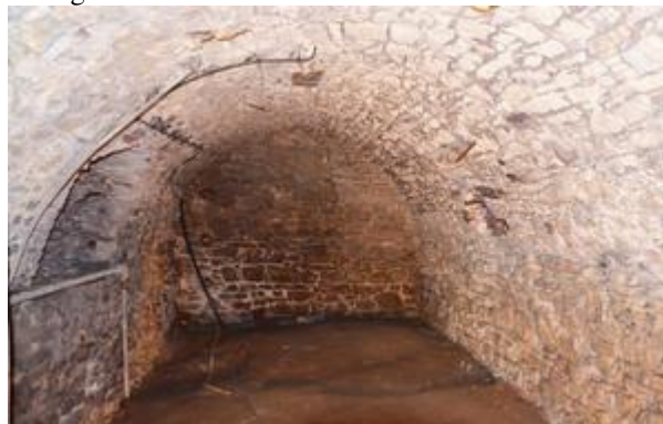
Das Kellergewölbe besteht aus Findlingen.
